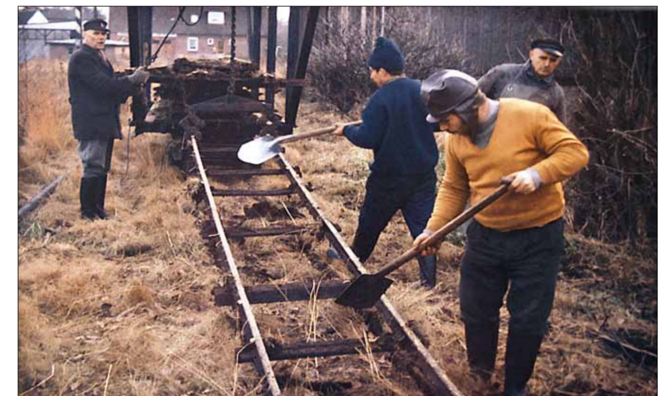
Entfernen der Schienen an der Torfstraße, 1973
